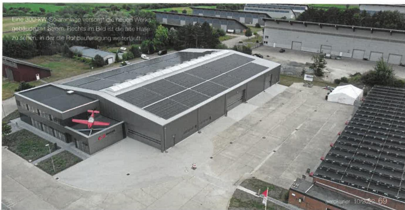
Eine 300-kW Solaranlage versorgt die neuen Werksgebäude mit Strom. Rechts im Bild ist die alte Halle zu sehen, in der die Rohbaufertigung weiterläuft.
